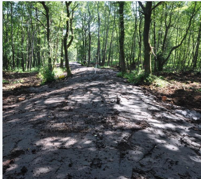
Folie mit Schlitzpflug eingezogen, Lösung für wertvolle Bestände
