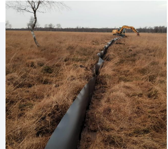
Folie mit Schlitzpflug eingezogen, Lösung für wertvolle Bestände
