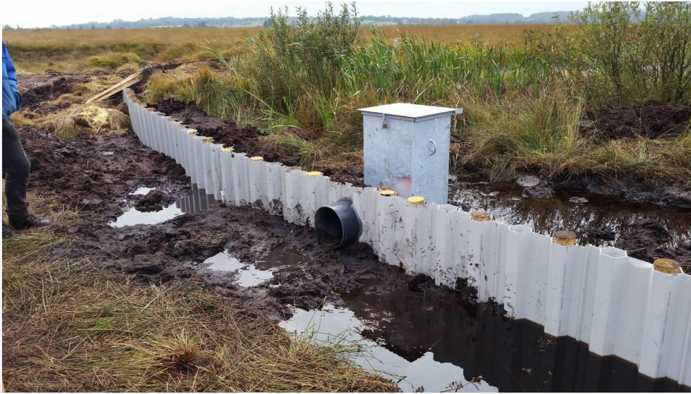
Recyclingspundwand mit sichernden Pfählen und regulierbarem Überlauf
